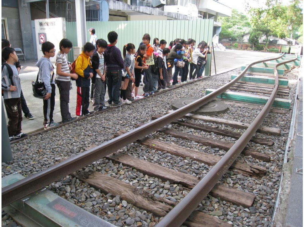
地震過後的彎曲鐵道
