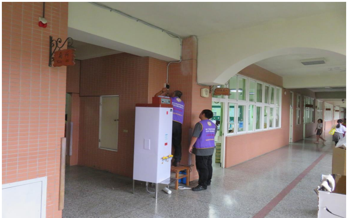
檢查飲水機線路確保安全
